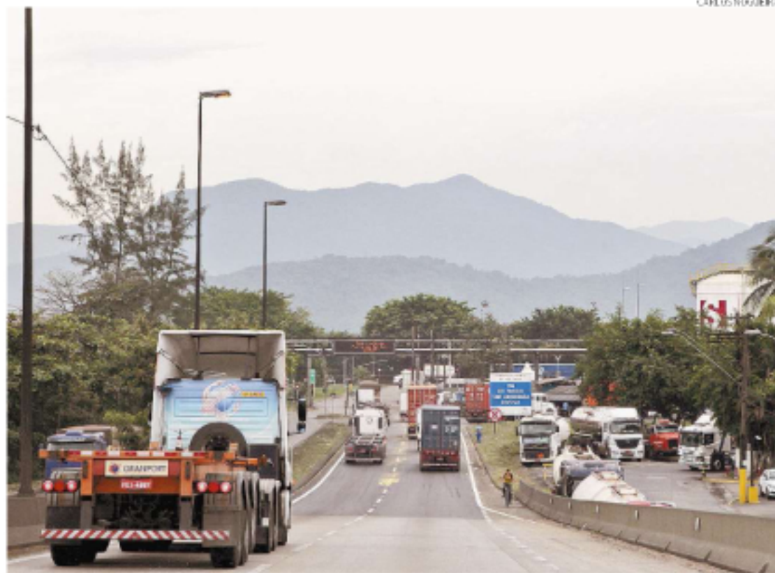
Viaduto da Alemoa, no Porto de Santos: obra a ser projetada facilitará o acesso à Margem Direita do complexo
