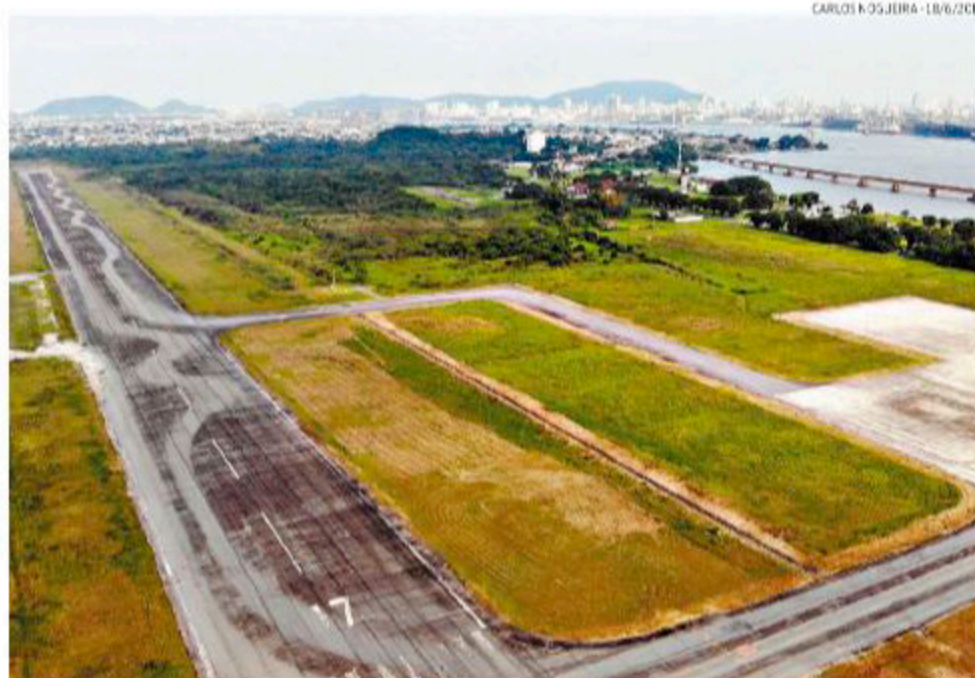
O recapeamento da pista, que possui 1.390 metros de extensão, está nos planos para o início dos trabalhos
