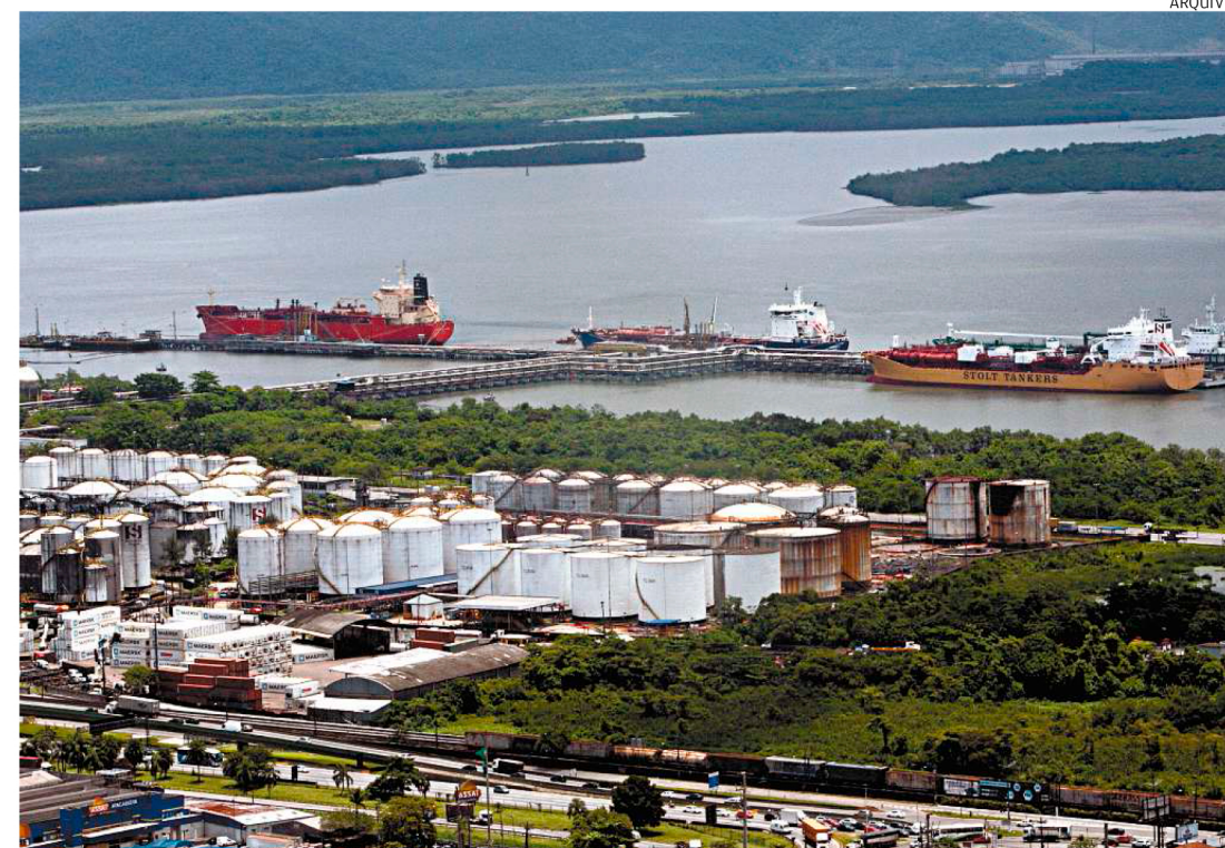
Pier da Alemoa, na Margem Direita do Porto de Santos: berços são destinados à operação de líquidos
