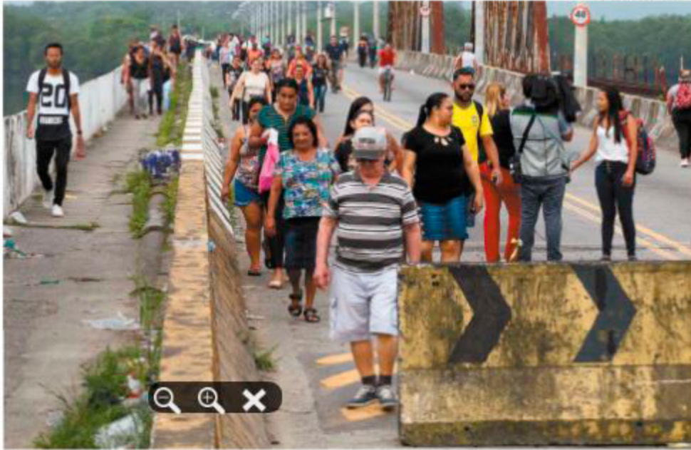
Juiz mandou interditar a ponte por problemas estruturais. Pessoas atravessam as duas margens a pé, e...
