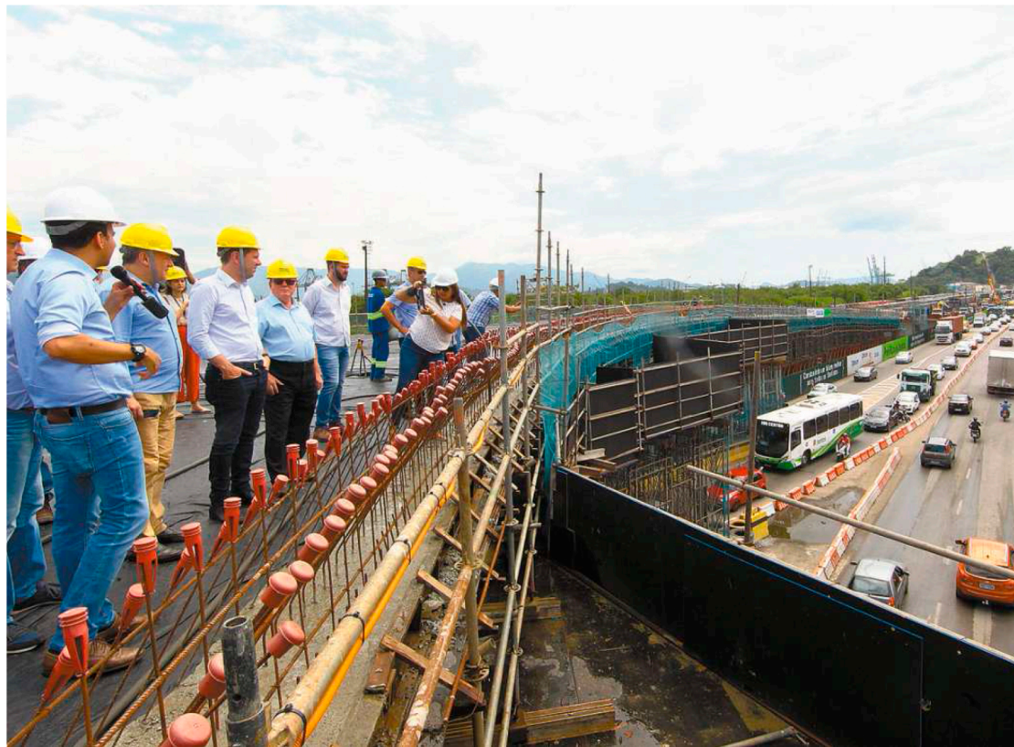
Ontem pela manhã, comitiva de empresários visitou viaduto que está em construção na entrada de Santos
