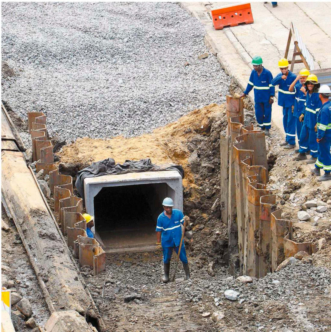
Na entrada de Santos, chama atenção a troca de tubulações, o que permitirá o melhor escoamento da água
