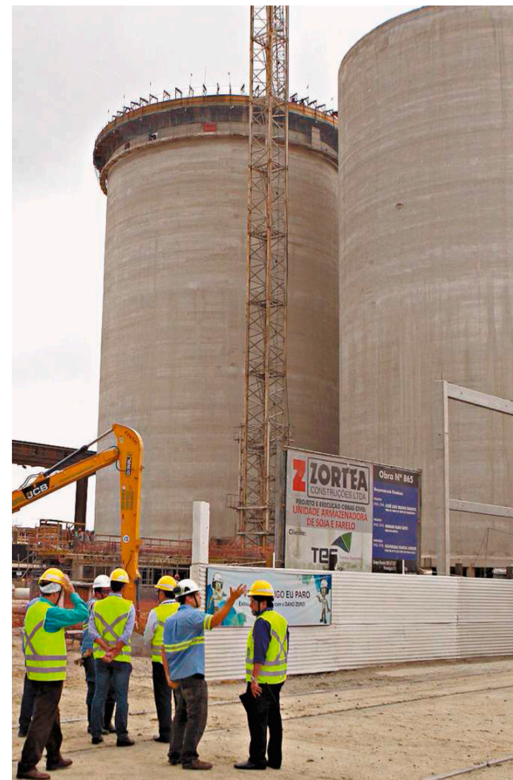
TES ganhará conjunto de 11 silos para armazenar grãos e farelos
