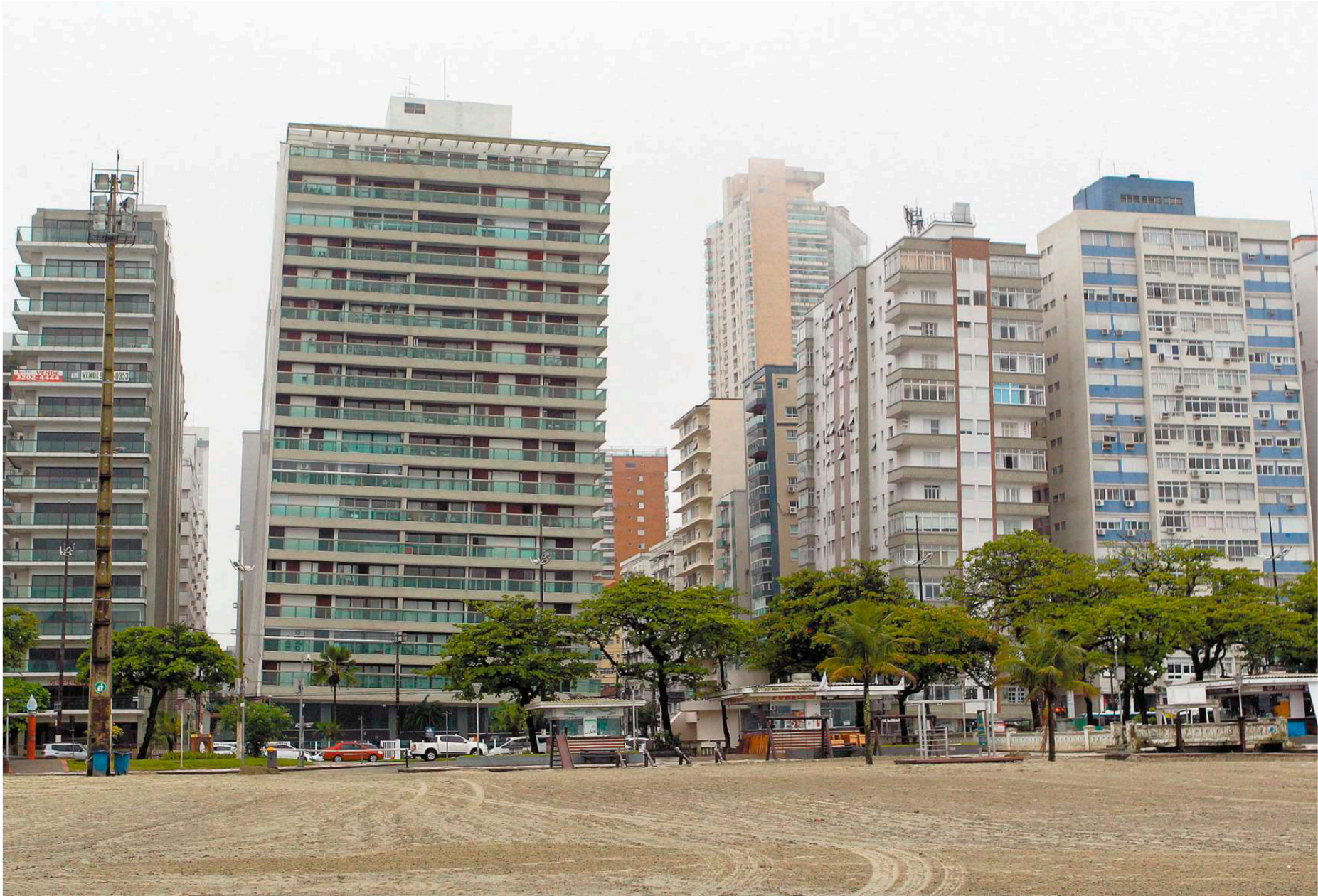
Seis anos atrás, os prédios incluídos em um grupo técnico tinham desaprumo de 50 centímetros a 1,80 metro, da base ao topo. O Município está intimando outros condomínios
