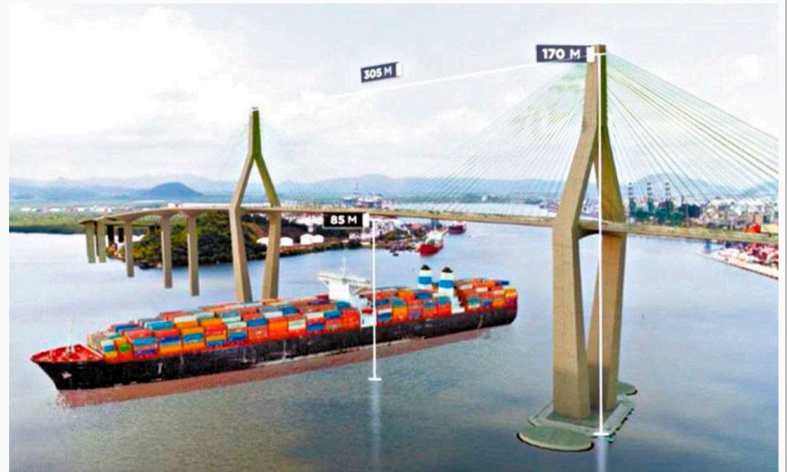
Estudos da Ecovias indicam que a ponte não acarretará restrições à navegação no canal do Porto
