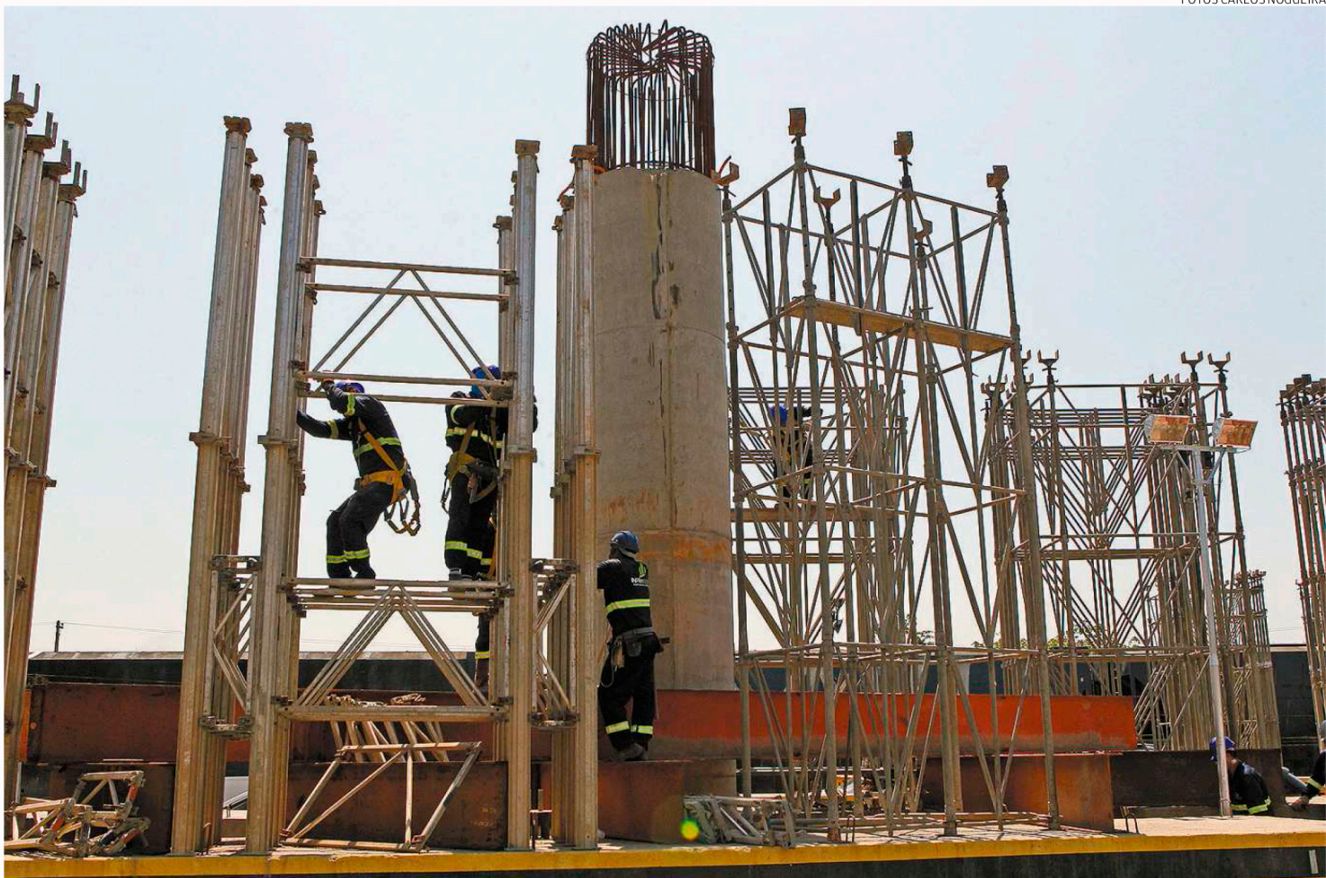
Fechamento será necessário para instalação das estruturas de sustentação do viaduto que ligará as avenidas Martins Fontes e N. Sª de Fátima
