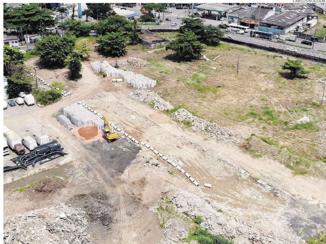
A área onde será construído o centro de convenções já tem sinais de obras em andamento
