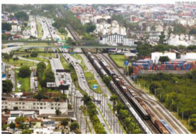
Novo acesso ao Porto de Santos será construído na Alemoa e integrará obras da entrada da Cidade
