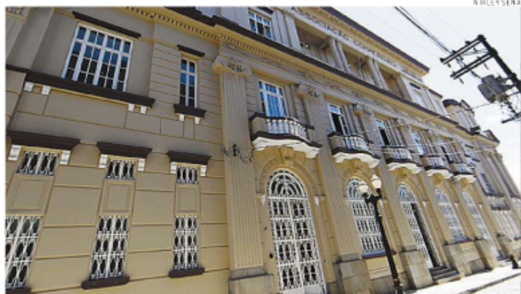
Tombada pelo patrimônio histórico, fachada do prédio foi lavada e restaurada
