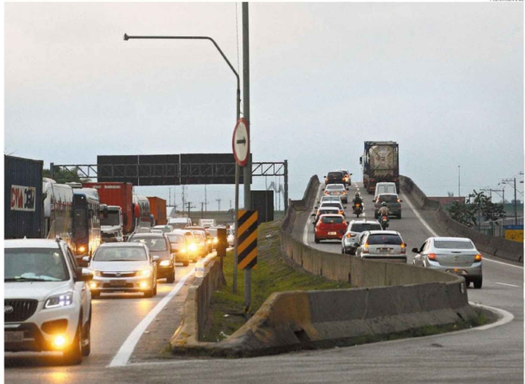
Na segunda-feira a concessionária começa o projeto, orçado em R$ 270 milhões, e que prevê um viaduto ao lado do atual ‘elefante branco’
