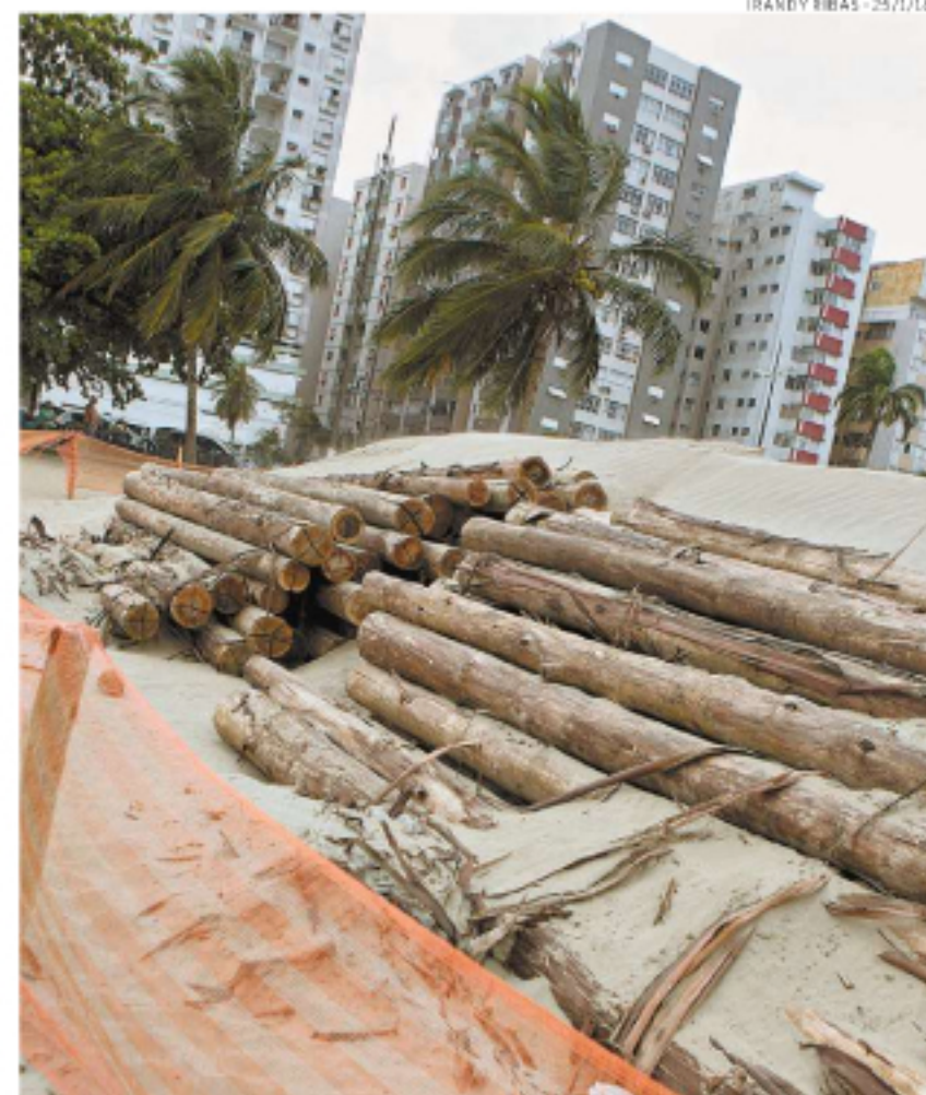
Obras paradas na praia: trabalho não pode coincidir com ressacas
