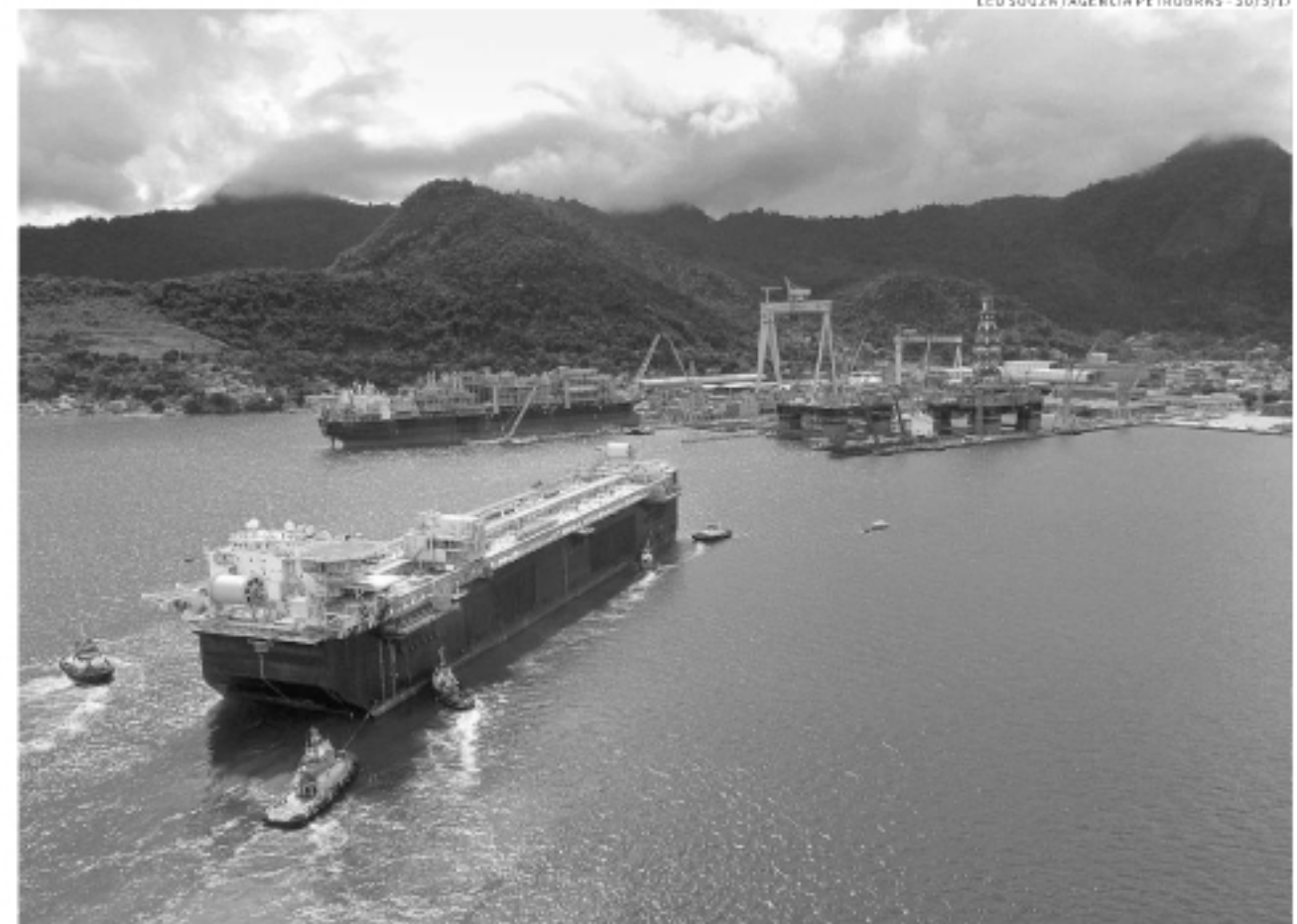
P-69, em fase de conclusão em Angra dos Reis: construção movimenta centenas de milhões de dólares
