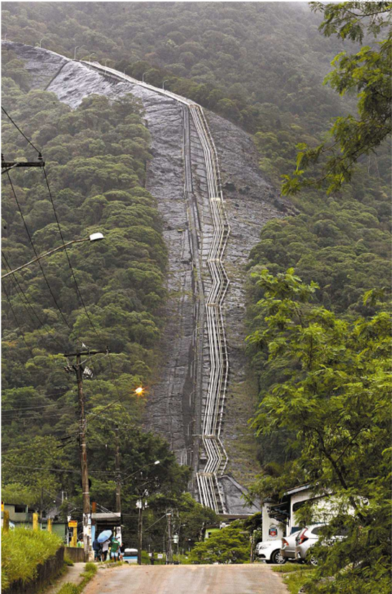
Dutos da Petrobras na Serra do Mar, em Cubatão: alta na produção não freou diminuição dos repasses
