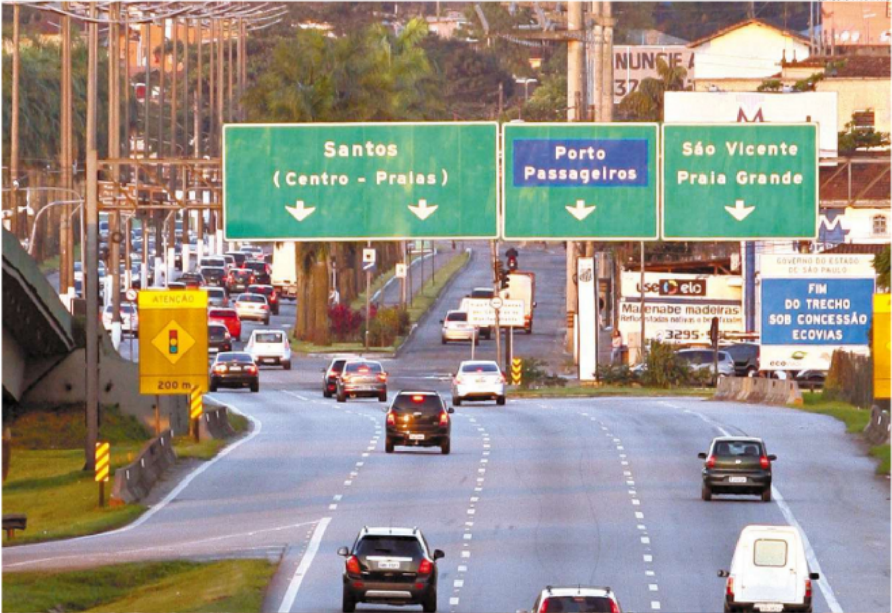
Esta etapa inclui a retificação da Pista Sul da Via Anchieta, com interligação das vias marginais sob novo viaduto no km 65 no sentido Santos
