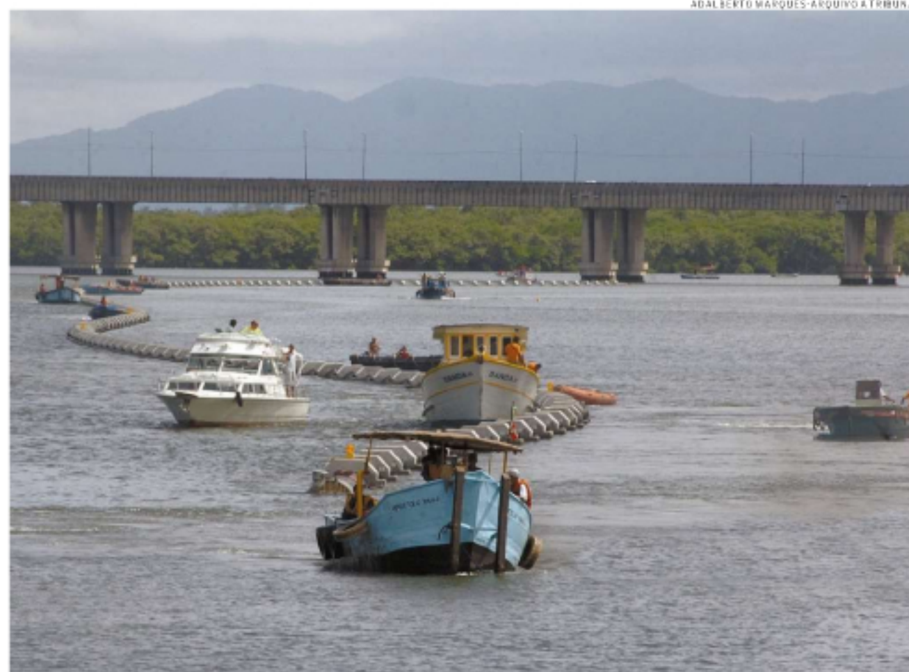
Imagem da construção do Emissário Submarino de PG, cuja obra teria rendido a Papa e Alckmin caixa 2
