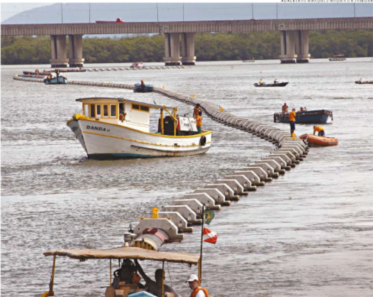
Os dutos sendo instalados, na altura da Vila Caiçara, em 2009: ao todo, são 4,65 km, sendo 3,3 km submersos
