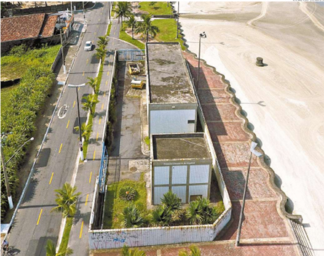
A estação elevatória de esgoto é uma das partes do sistema, que custou, no total, R$ 280 milhões
