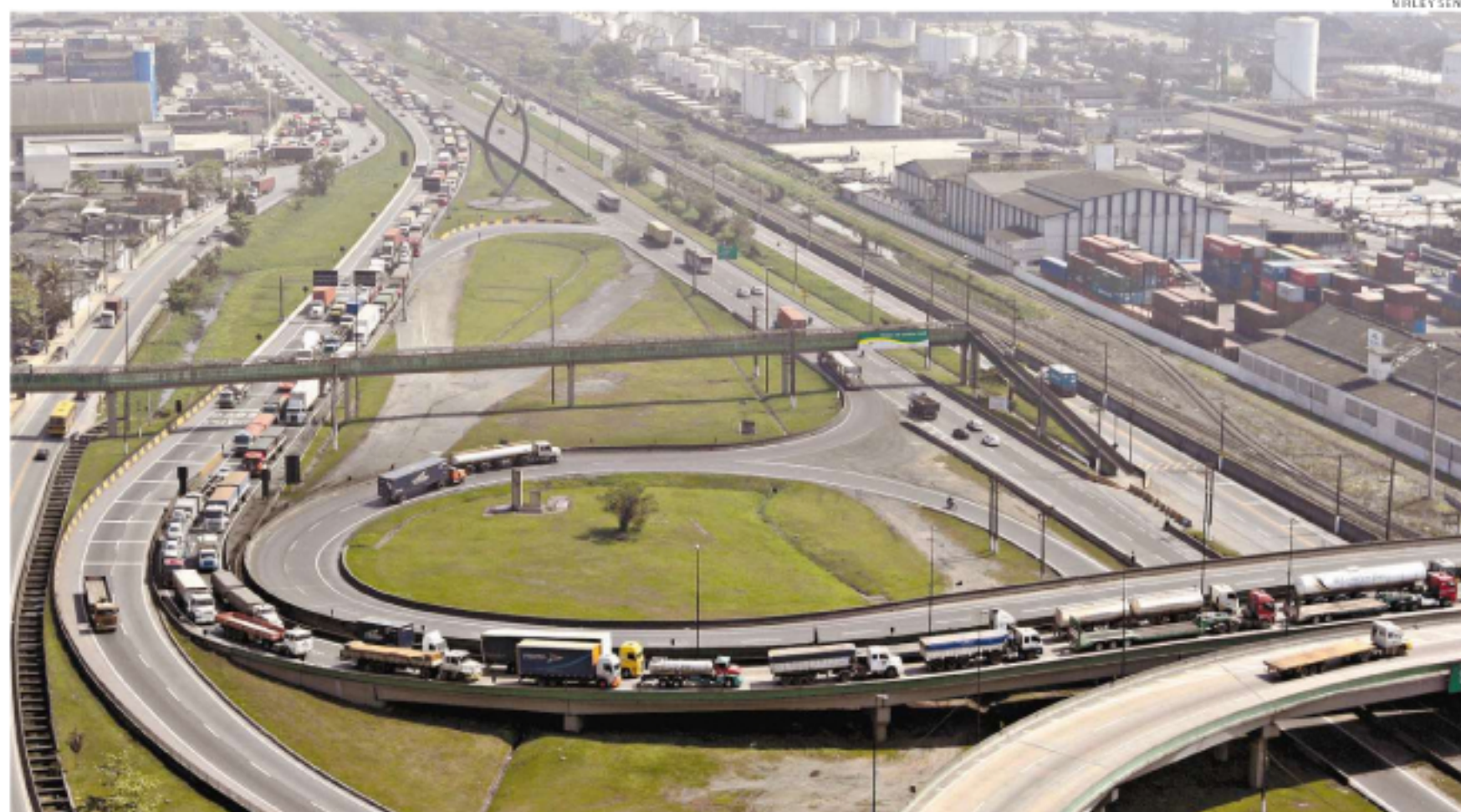
Governo Federal construirá uma nova alça no Viaduto da Alemoa, principal acesso rodoviário à Margem Direita (Santos) do complexo marítimo
