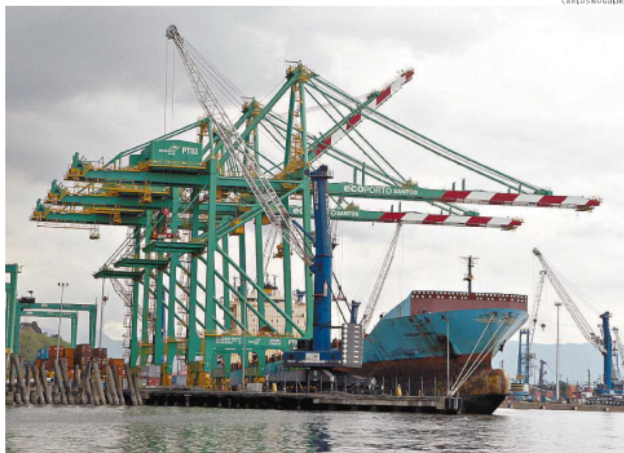
Localizado no Cais do Saboó, Ecoporto informou à Antaq planos de aportar R$ 142 milhões em seu terminal
