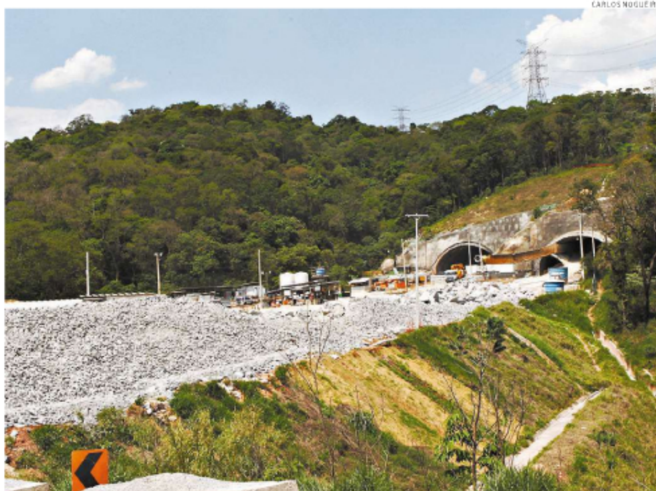
Construção do Trecho Norte está atrasada, principalmente, devido à demora na desapropriação de áreas
