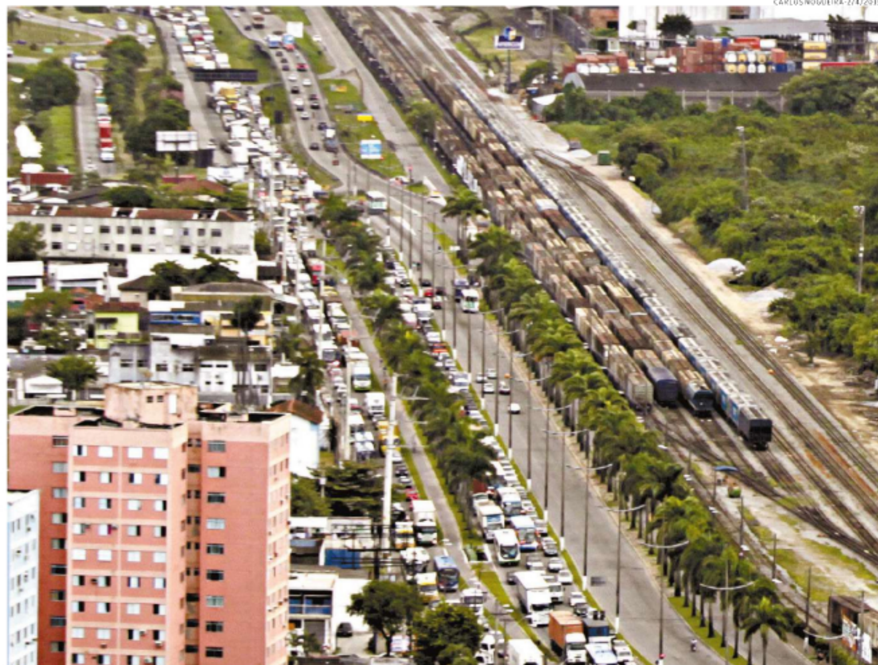
Toda a intervenção na entrada de Santos prevê mudanças em área de 25 quilômetros, entre o Centro e a região da Zona Noroeste
