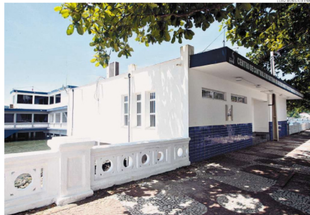
Base do VTMISS funcionará na antiga Ponte de Inspeção Naval da Capitania dos Portos, na Ponta da Praia
