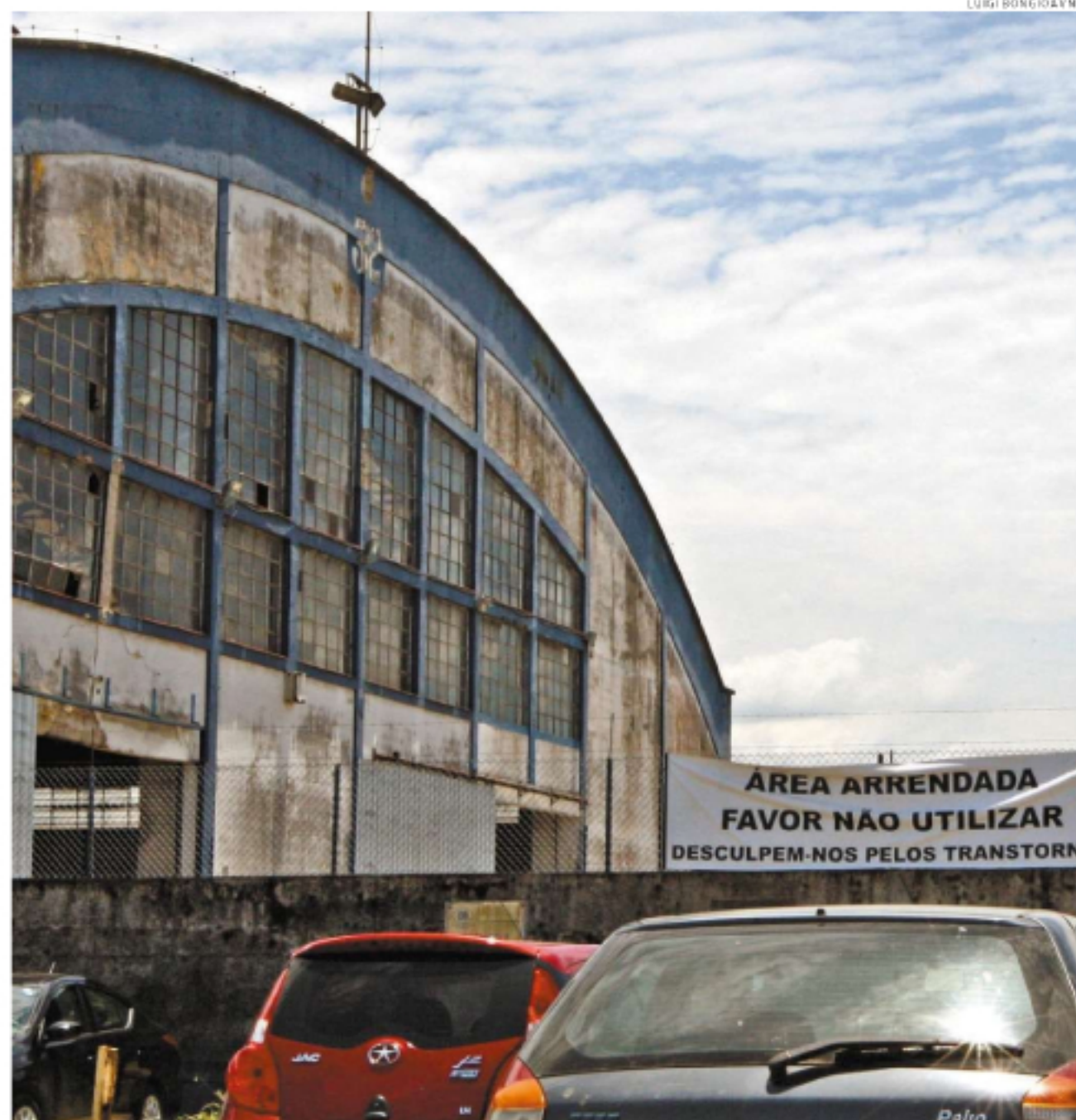
Programação do projeto prevê a demolição do Armazém 32, na região do Macuco do Porto de Santos
