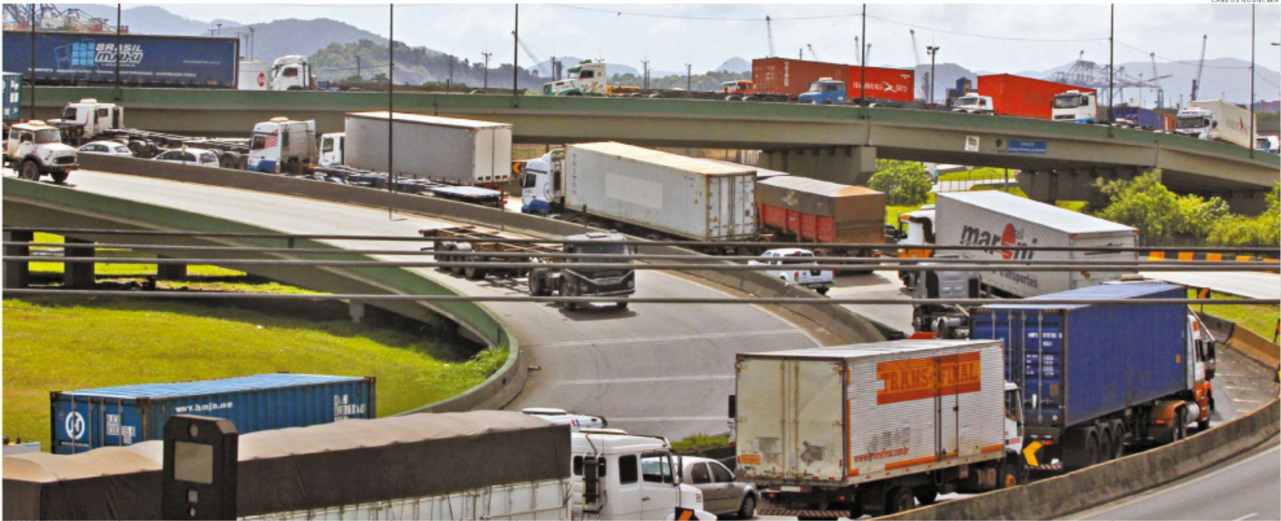
A ser implantado pelos governos Federal, Estadual e Municipal, o novo sistema viário da entrada de Santos prevê mais acessos ao Porto, com a construção de uma 2ª alça no Viaduto da Alemoa (na foto) e de um novo viaduto
