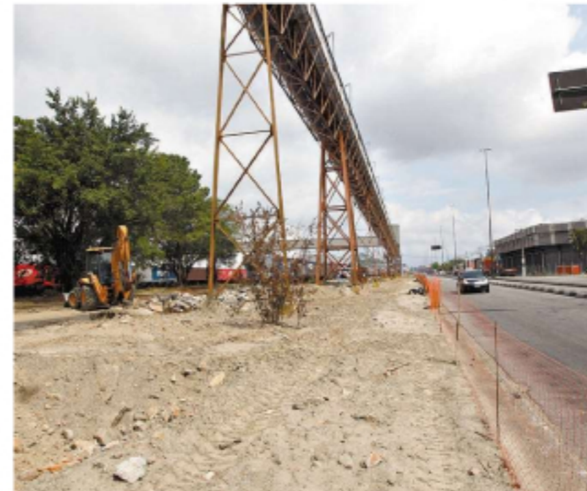
Ramais serão instalados entre armazéns e a futura Avenida Perimetral
