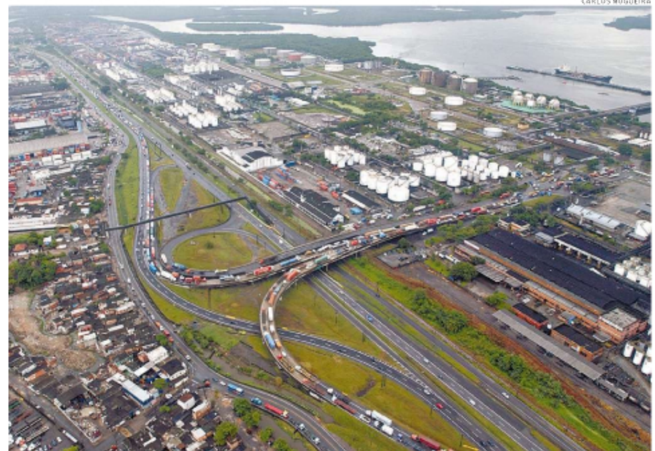
Docas defende mais um acesso rodoviário à região portuária, além do Viaduto da Alemoa (na foto)
