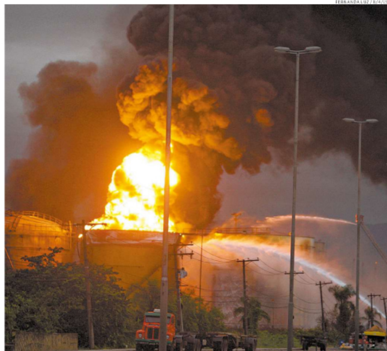
Em abril de 2015, incêndio nos tanques da Ultracargo, na Alemoa, só foi controlado após nove dias
