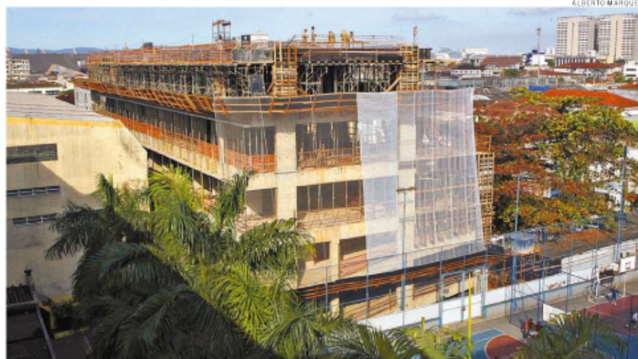
Obras do edifício tinham conclusão prevista para janeiro deste ano; agora, data fixada é 13 de novembro
