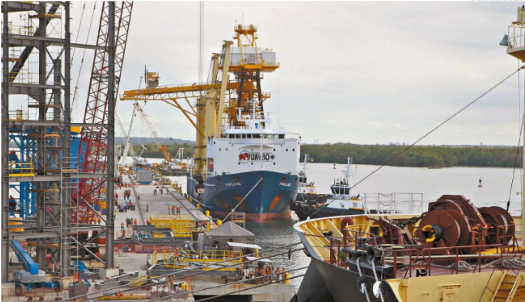
Localizado às margens do Canal de Piaçaguera, terminal portuário recebeu um de seus novos shiploaders no início da tarde de ontem
