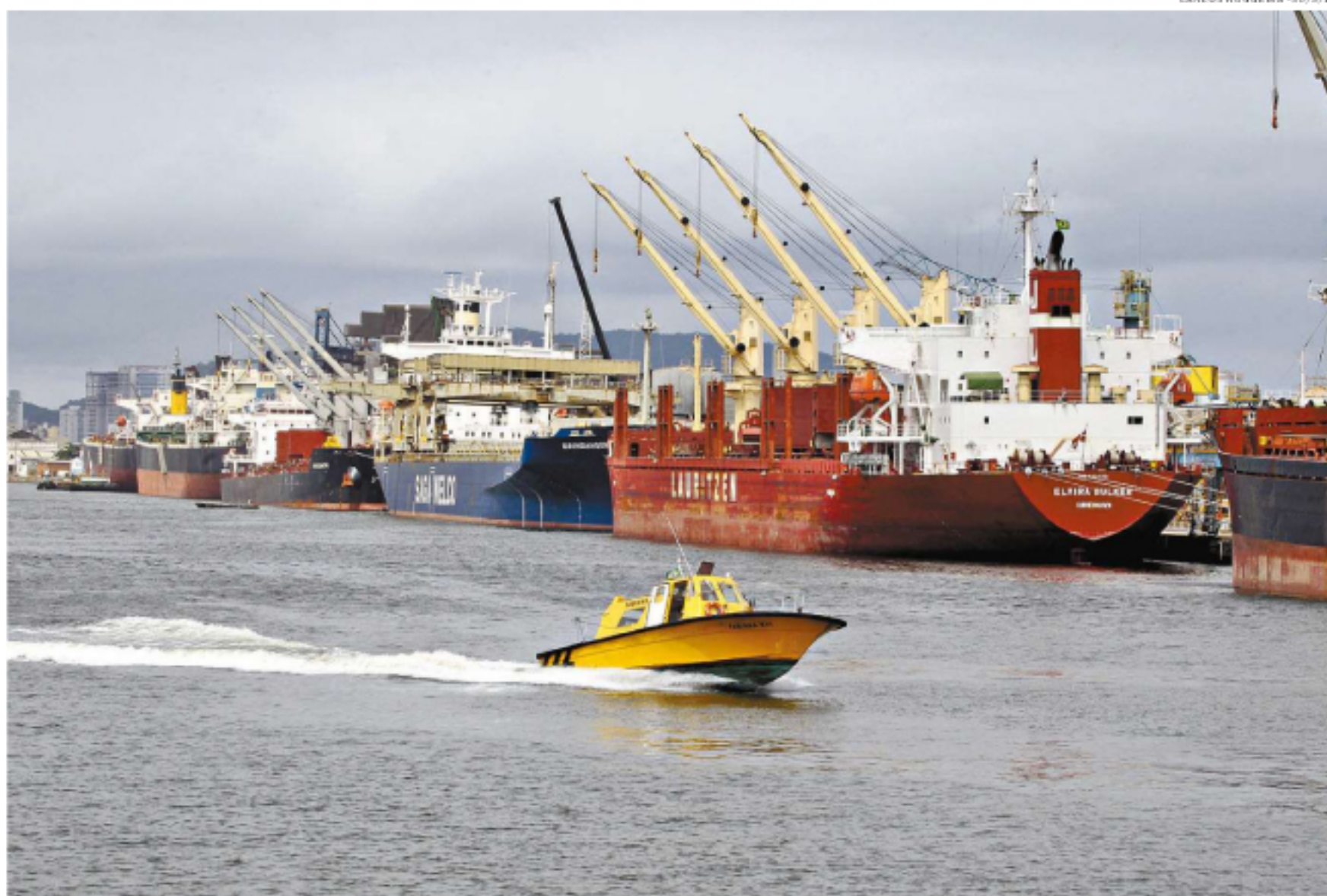
Manutenção da profundidade do canal do Porto de Santos é realizada a partir de contratos emergenciais firmados pela Companhia Docas
