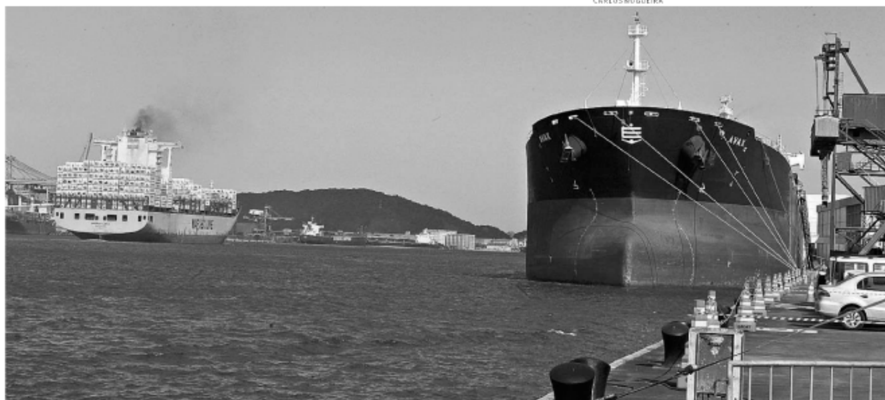
EEL Infraestrutura será responsável pela dragagem dos berços de atracação, das bacias de evolução e do canal de navegação do Porto de Santos
