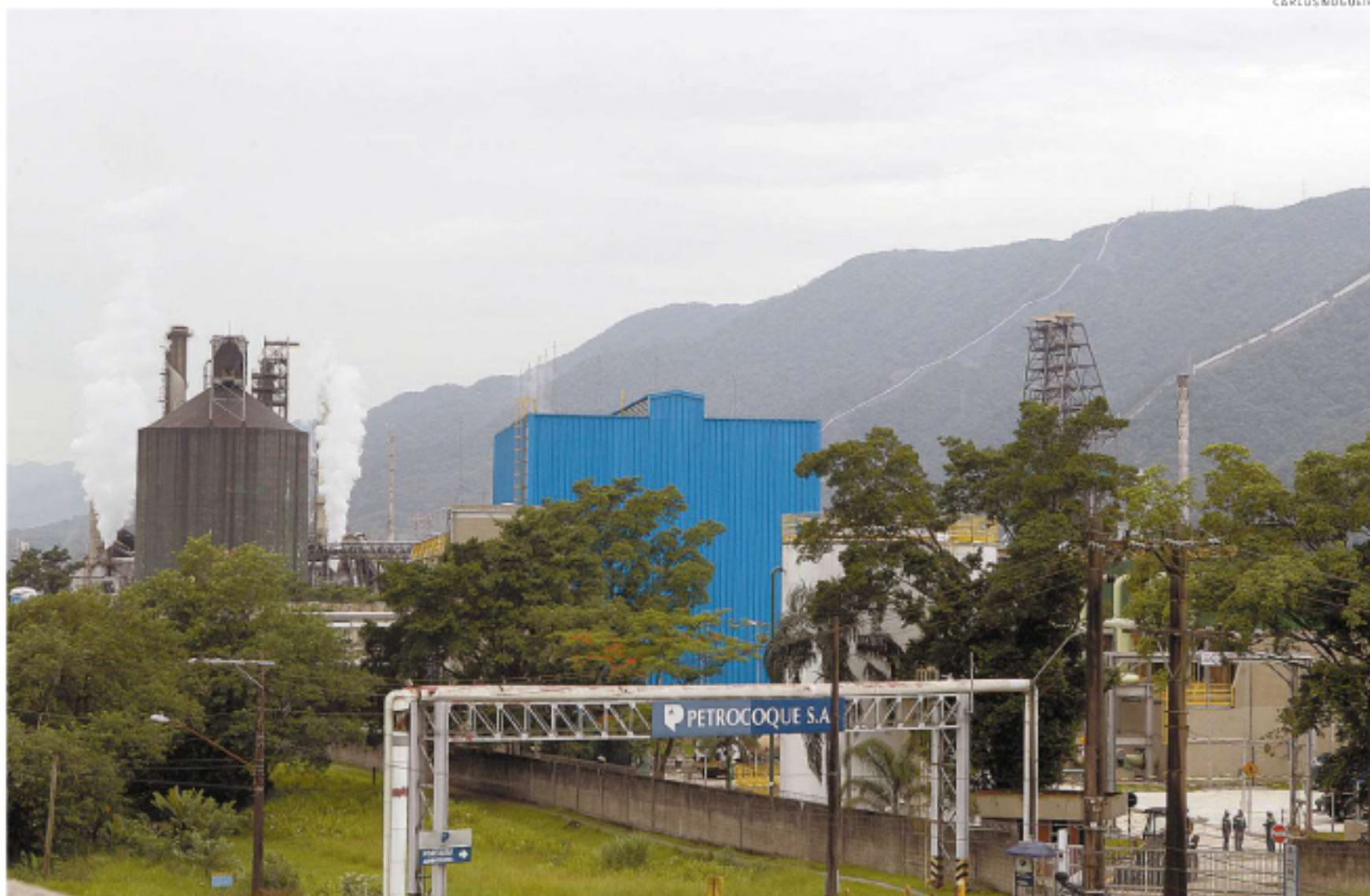
O equipamento (detalhe em azul) está em fase de acabamento e terá capacidade instalada para gerar aproximadamente 18 MWh de energia
