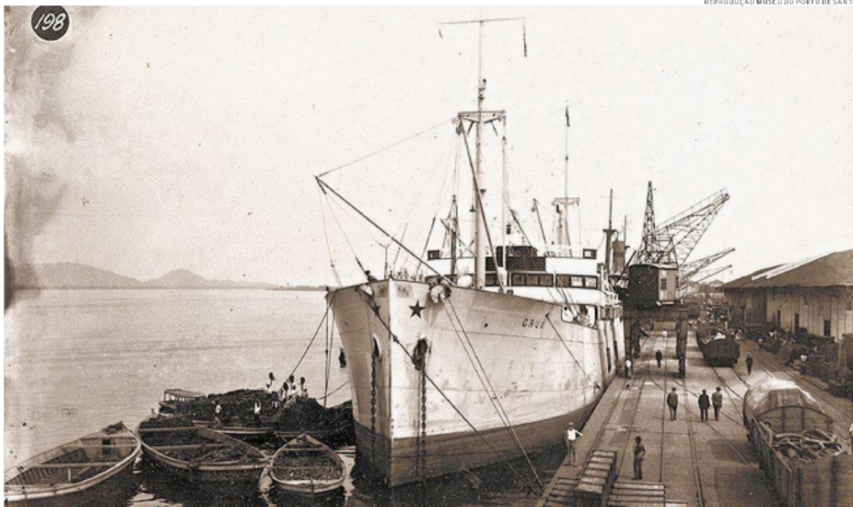
Construção da maior parte dos trechos de cais do Porto de Santos ocorreu no século passado, durante a gestão da Companhia Docas de Santos
