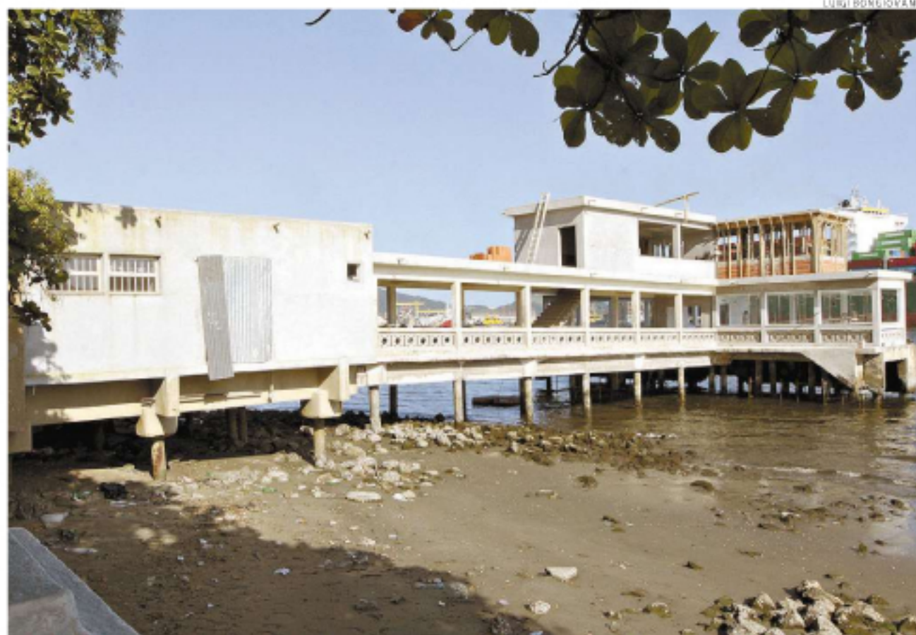
Centro de Controle de Operações do VTMIS será implantado na antiga ponte naval, que passa por reformas
