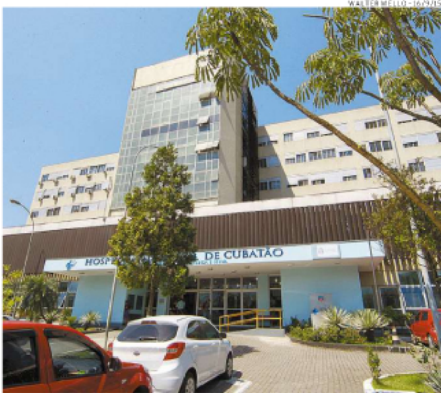
Prefeita teme pela paralisação dos trabalhos no Hospital Municipal
