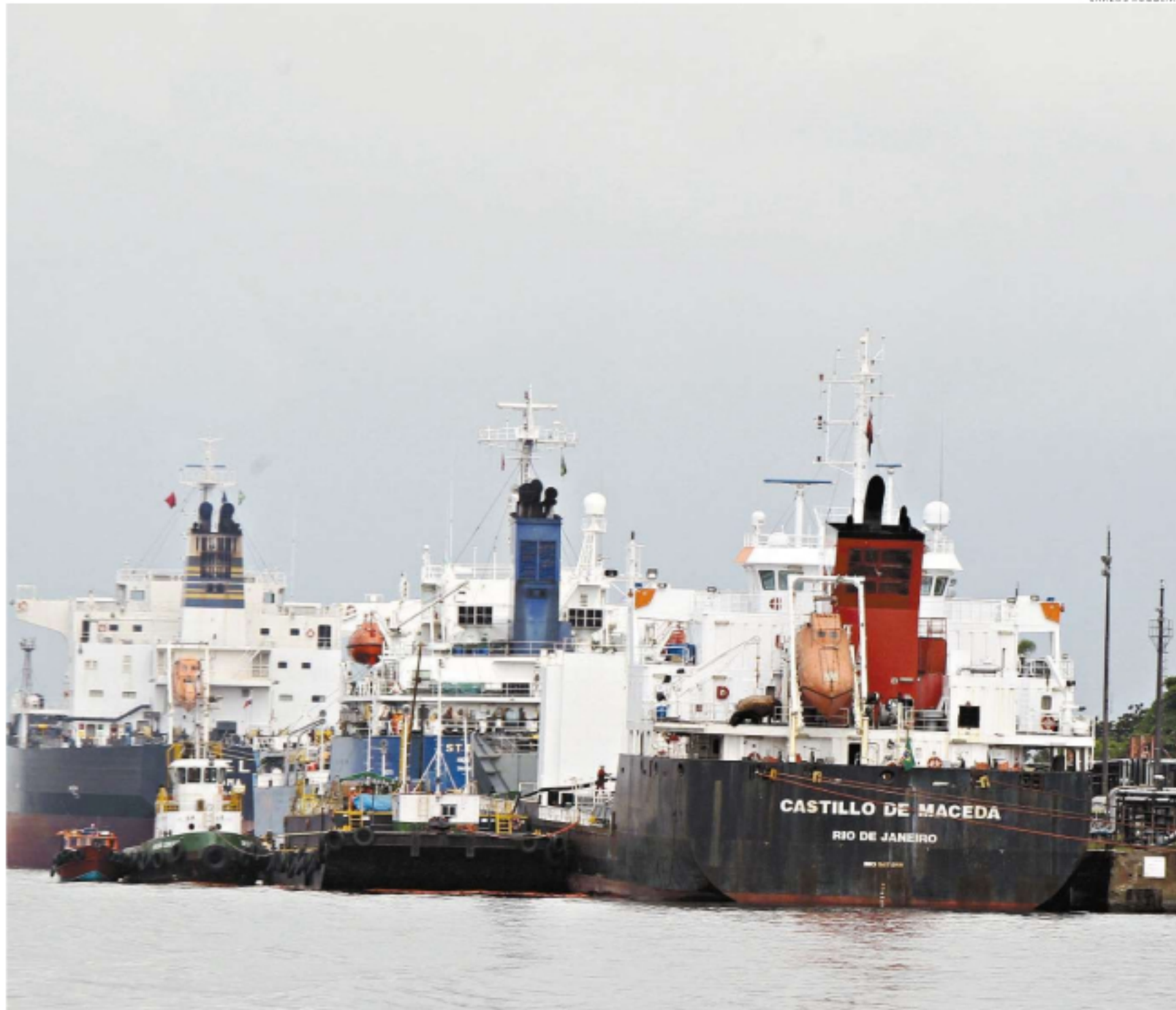
Serviço de manutenção da profundidade dos berços de atracação do Porto de Santos foi interrompido no último dia 10 de dezembro
