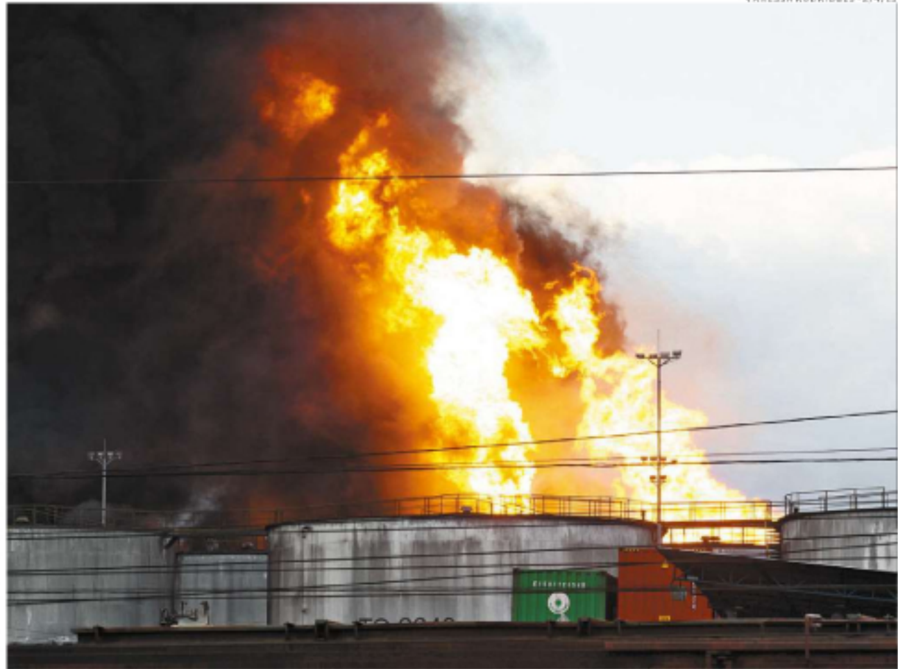
Incêndio na Ultracargo, na Alemoa, em 2015, deu início a “pente-fino” da Cetesb em áreas de tanques
