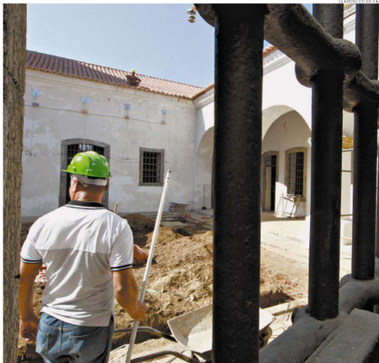
O restauro deverá ser concluído até fevereiro ou março e reabertura, entre final de maio e início de junho
