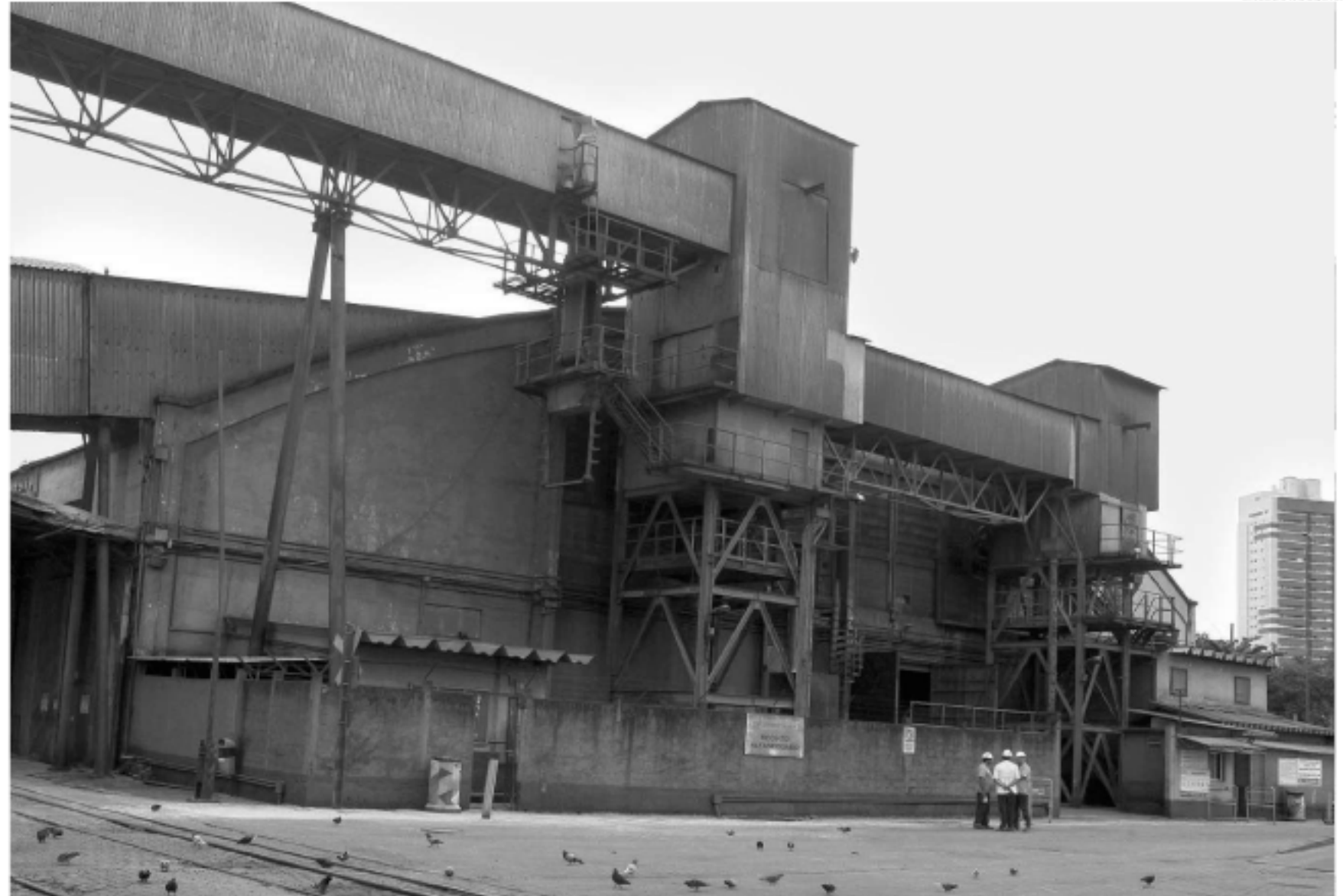
Armazém XLII (42 externo) é uma das instalações que integram o lote a ser licitado no Corredor de Exportação, na Margem Direita do Porto
