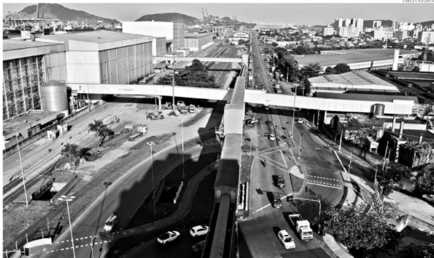
Construção do novo trecho da Avenida Perimetral, entre o Macuco e a Ponta da Praia, já recebeu R$ 10 milhões, mas aguarda mais verbas
