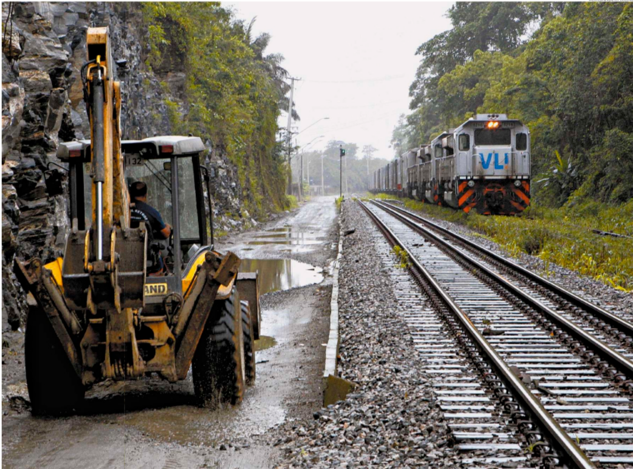
Segundo a concessionária Rumo-ALL, trabalhos na expansão da malha férrea regional devem ser concluídos ainda neste mês, possibilitando a expansão da utilização do modal no Porto
