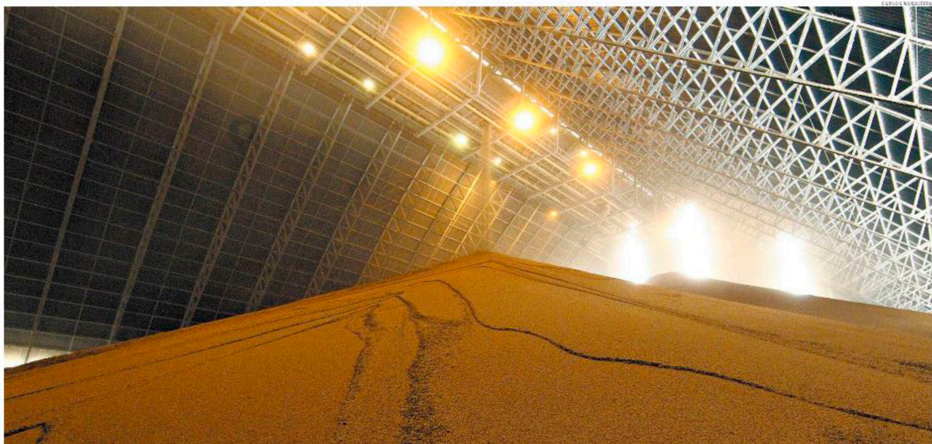
Armazém de soja no Porto de Santos: equipamento estudado por alunos pode reduzir as emissões de material particulado dos grãos durante sua movimentação e sua armazenagem nas instalações do complexo
