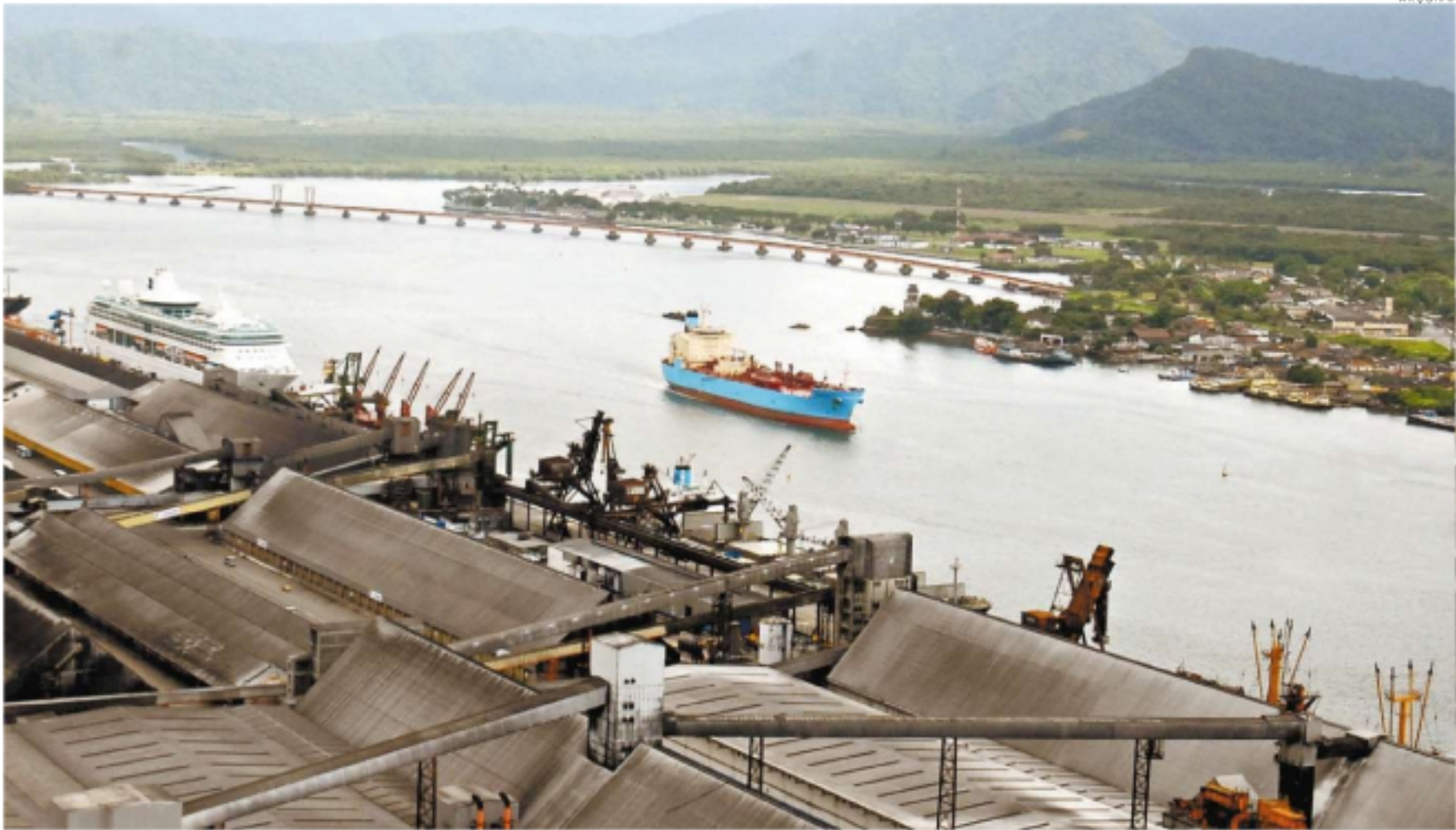
Secretaria de Portos contratou o Consórcio Draga Brasil para fazer a dragagem de aprofundamento e alargamento do canal de navegação de Santos
