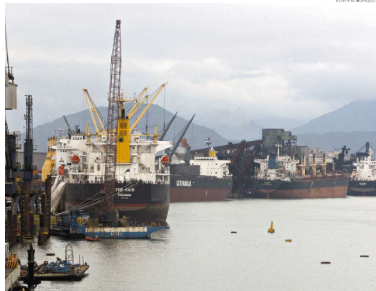
A Dratec Engenharia é a responsável pela manutenção das profundidades dos berços até o próximo dia 4
