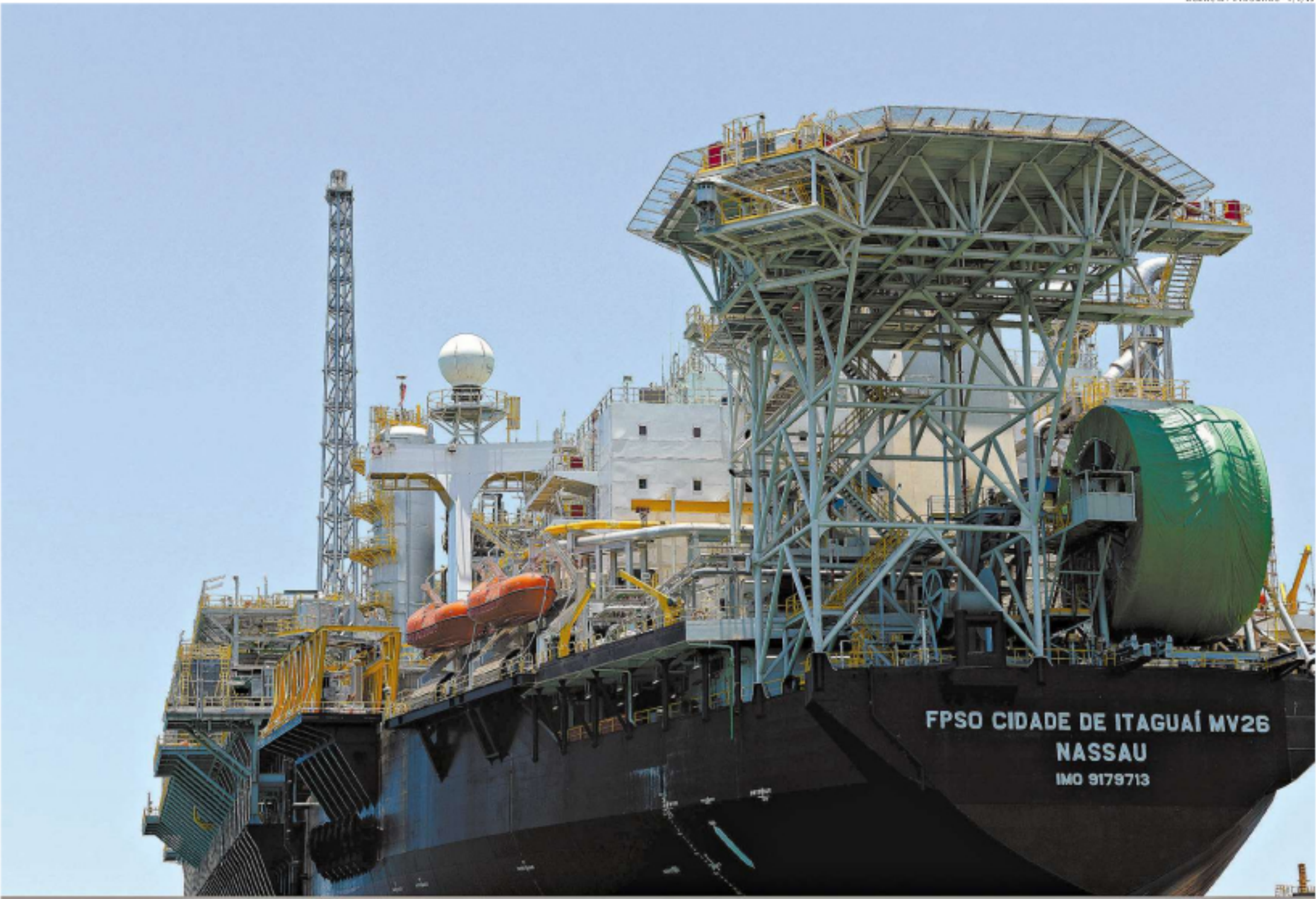
Plataforma Cidade de Itaguaí, no estaleiro Brasfels, pouco antes de partir para a região de Lula: capacidade para armazenar 1,6 milhão de barris de petróleo no campo líder do País
