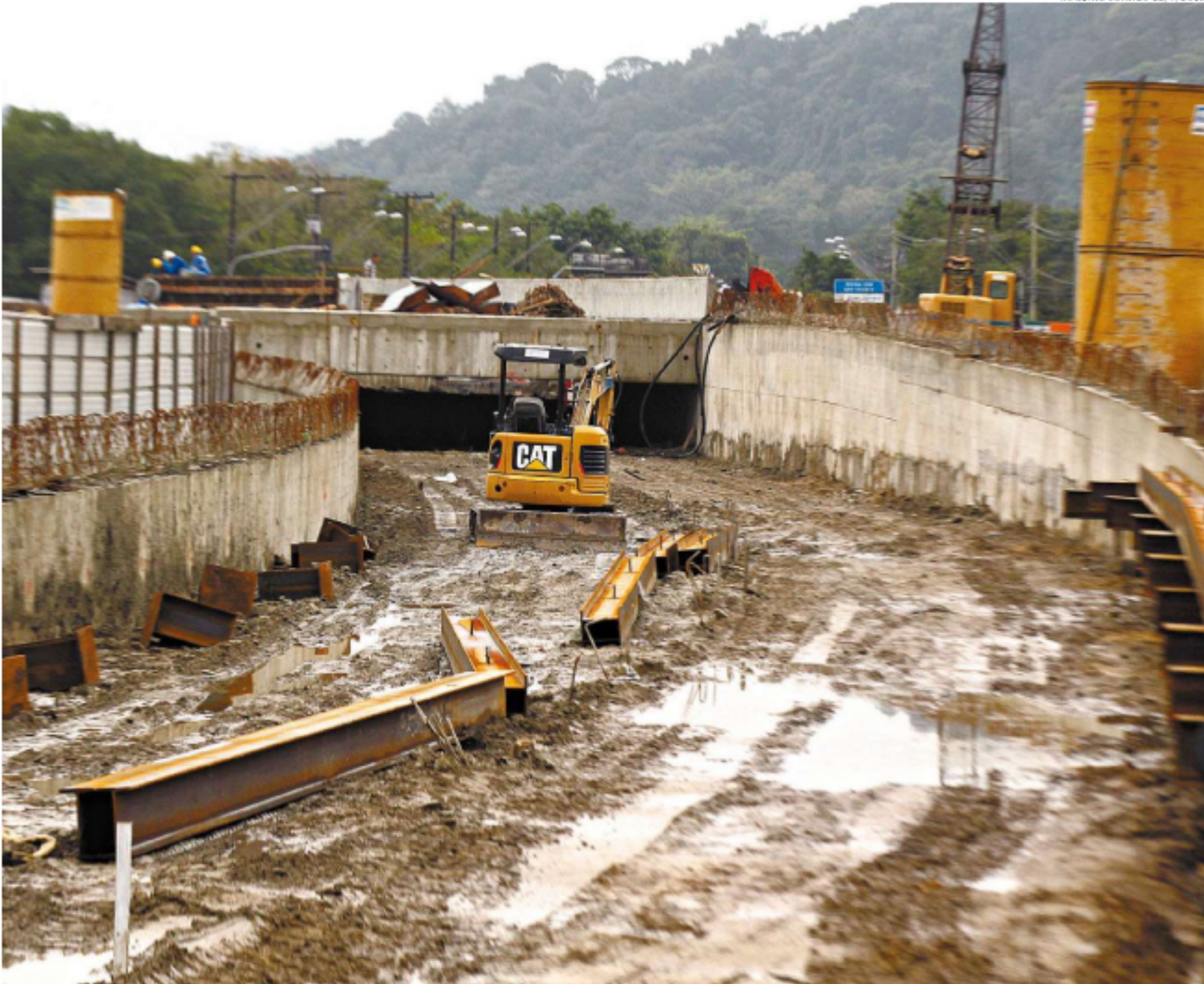
Intervenções estão em fase de escavações, consolidação de paredes laterais de diafragma e execução da laje de fundo da passagem inferior
