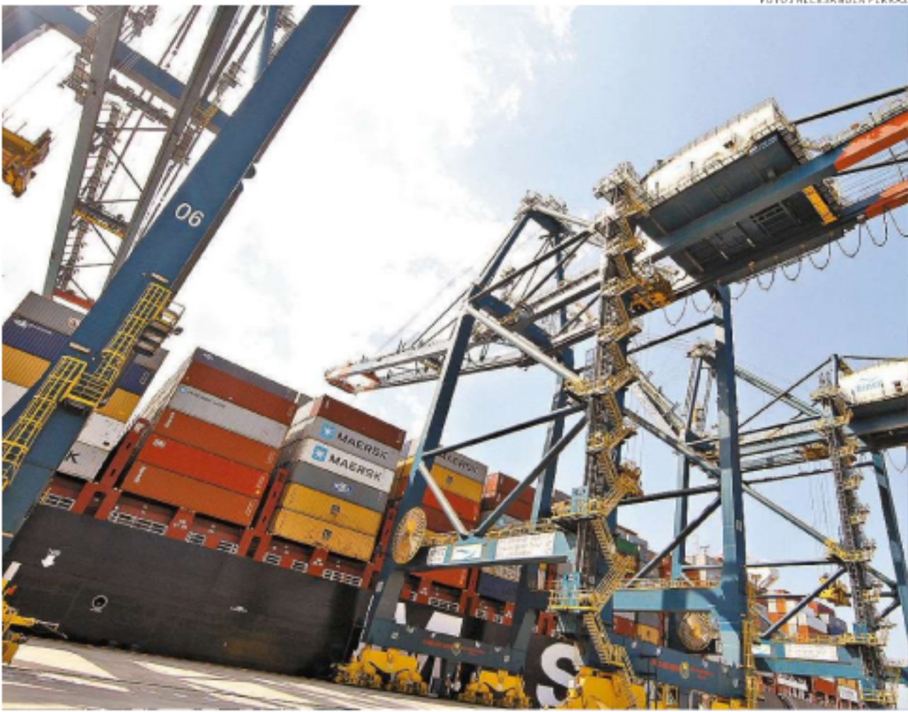
BTP opera um terminal especializado na movimentação de contêineres, localizado na região da Alemoa
