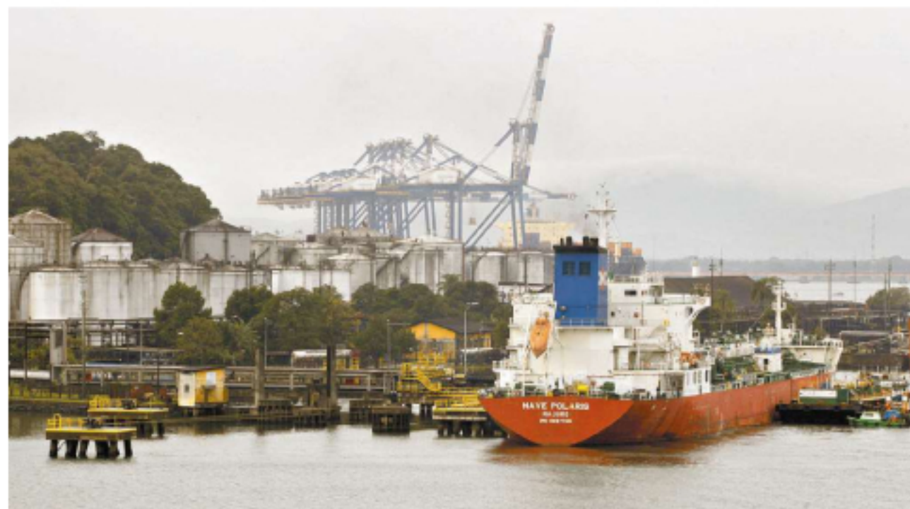
A Ageo opera seus terminais de líquidos na Ilha Barnabé, na Margem Esquerda do complexo santista
